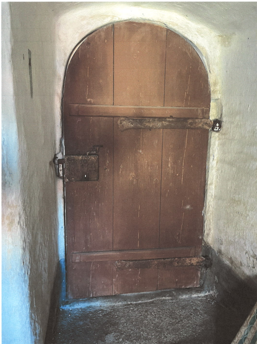
Foto č. 6 - Jednokřídlové interiérové dveře - půloblouk
