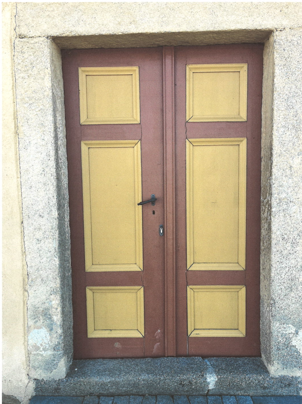
Foto č. 2 - Vchodové dveře do kostela z exteriéru
